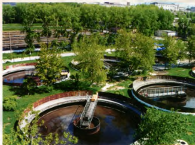
Очистные сооружения канализации МУП «Водоканал» Череповца
